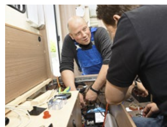
Die gesamte Testanlage wird vom Elektronik-Fachmann verkabelt.
